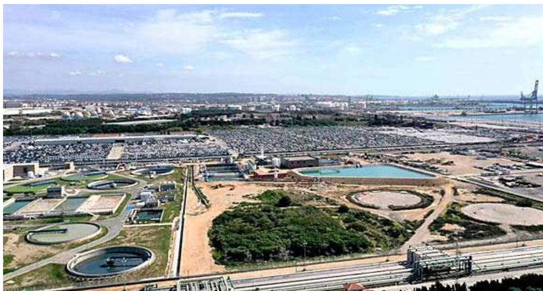
Aqualia ha diseñado y construido la Estación Depuradora de Aguas Residuales Industriales de Aitasa, que actualmente opera en Tarragona.
