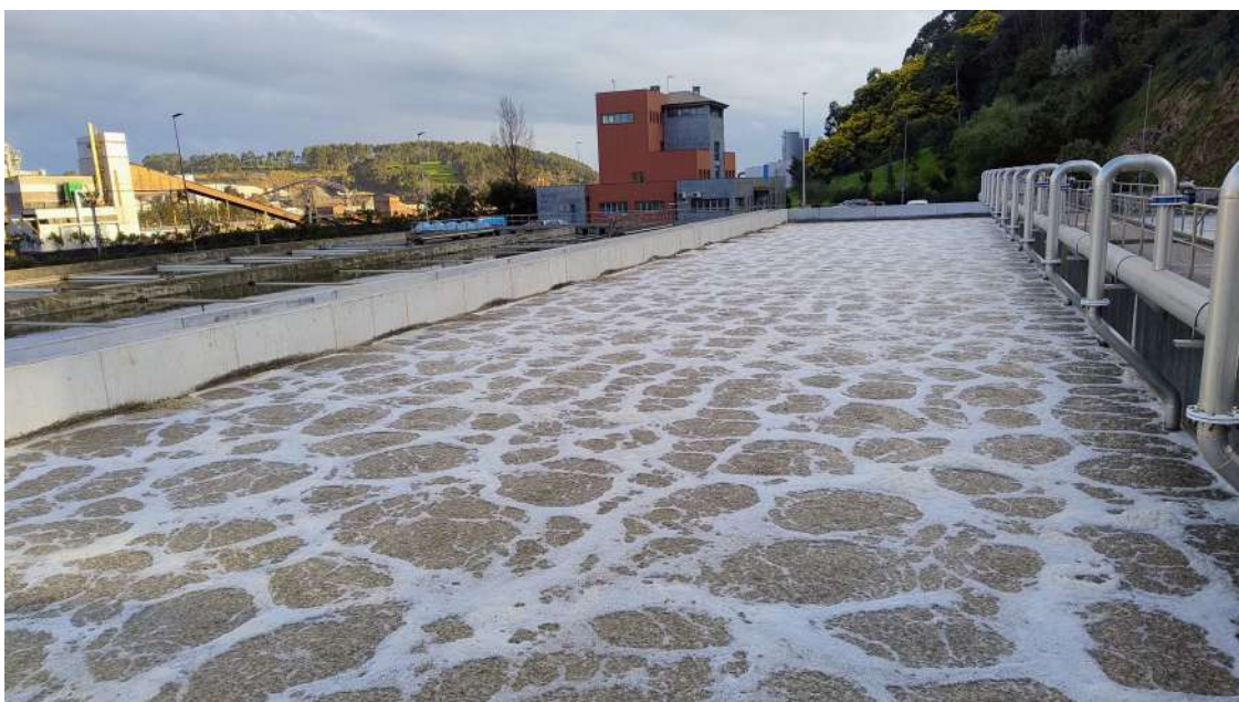
Veolia completa la modernización de la EDAR Gijón Oeste con sus tecnologías avanzadas que mejoran el tratamiento de las aguas residuales
