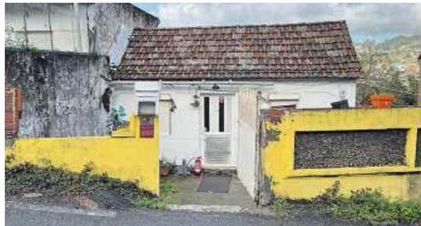
Vivienda okupada donde se originan los problemas, según los vecinos.
