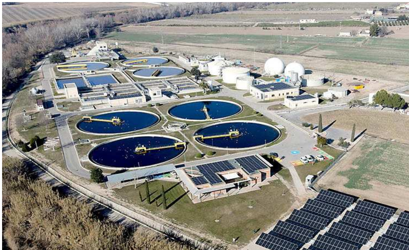
La empresa gestiona desde 1994 la EDAR de Lleida, que está transformando en una biofactoría.
