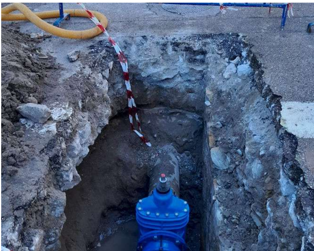
Imagen de archivo de unas obras en la red de Aqualia. Unas obras de Aqualia afectarán este miércoles al suministro de agua en algunas zonas de La Línea
