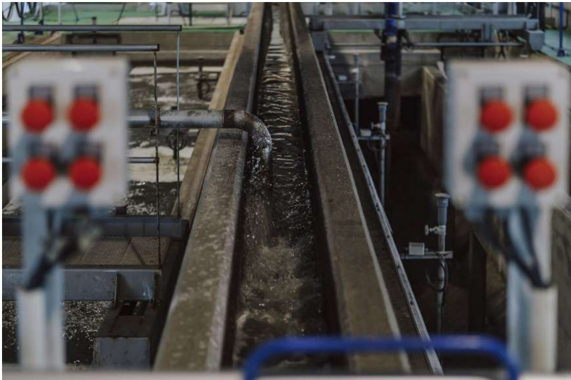
ACCIONA se adjudica la operación y mantenimiento de 12 depuradoras en Portugal
